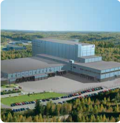
Das neue ökoeffiziente Arzneimittellogistikzentrum in Tampere, Finnland, erfüllt sowohl die Vorgaben der GDP-Richtlinie als auch die Anforderungen des Tamro ISO 9001-Qualitätssystems.
